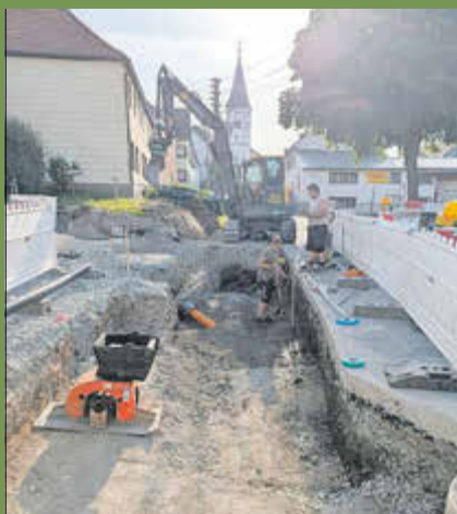
Noch bevor mit dem Gehweg begonnen werden konnte, mussten Kanäle und Elektrokabel im Untergrund verlegt werden, wie hier im August. Foto: M. Streit
