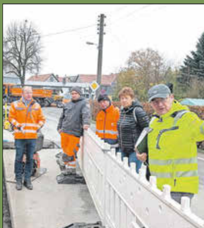
In den Bauberatungen gab es zahlreiche Probleme zu diskutieren und zu lösen. Hier im Bild (v.r.) Jörg Brunzel (ZWOS), Dagmar Seidler (Bürgermeisterin), Dirk Büttner (Ingenieurbüro Bechert), Michele Göppner und Frank Brendel (Schwall+Mayer). Foto: M. Streit
