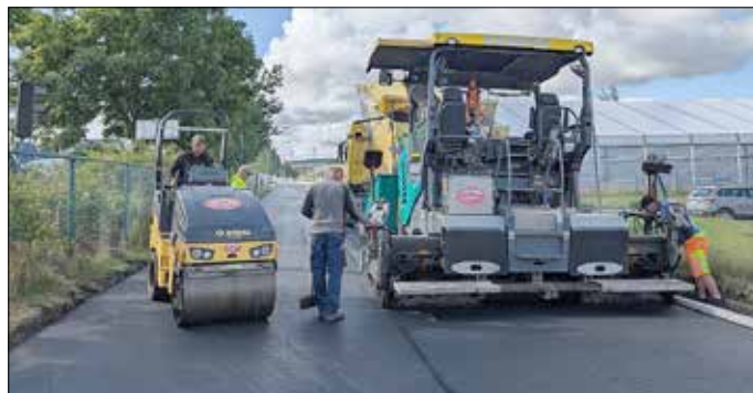
Nach über 30 Jahren intensiver Nutzung war die Erneuerung der Fahrbahn im Dittersdorfer Gewerbegebiet überfällig. Hier erfolgt gerade der Einbau der bituminösen Deckschicht.
