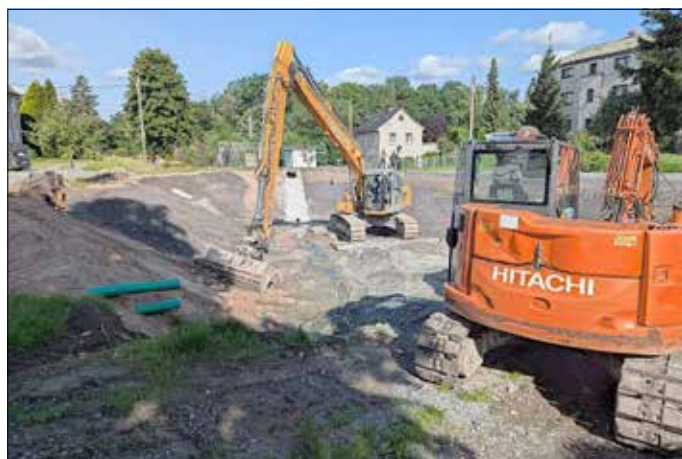
Eine KfW-Förderung ermöglichte die naturnahe Gestaltung des Mönchgrüner Dorfteiches. Der Bagger der Dittersdorfer Firma RK Landschaftsbau agiert auf der drei Meter tiefer liegenden Teichsohle.
