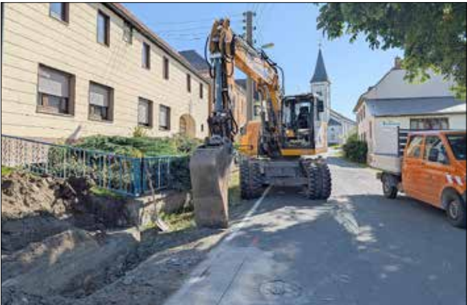
Nachdem die Neustädter Firma Schwall + Maier vor fünf Jahren die Teichmauer erneuerte, ist sie jetzt wieder vor Ort, um einen Gehweg zu errichten und Kanäle und Stromleitungen zu verlegen.
