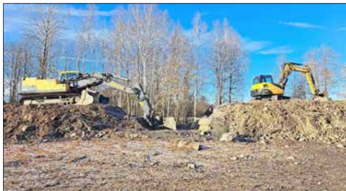
Baustelle Alter Teich - Suchgrabung nach einem Leck im Damm Foto: Stephan Umbach
