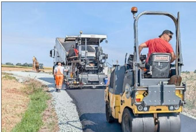
Einbau der Asphaltdecke auf dem Schleizweg in Pahnstangen
