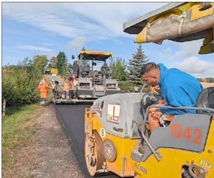
Die schadhaften Stellen wurden großflächig mittels Fertiger mit einer bituminösen Deckschicht überbaut.
