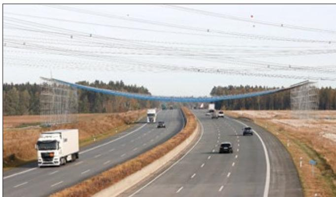
Für das Einbringen des Schutznetzes für die Montage der Leiterseile wurde die Autobahn am 27. September für eine Viertelstunde in beiden Richtungen voll gesperrt. Foto: Mario Streit
