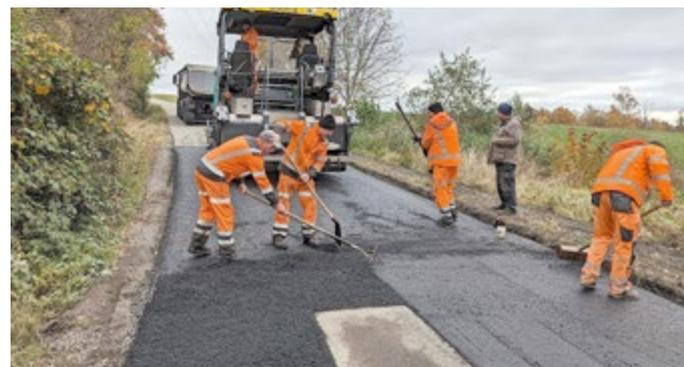
Arbeiter der Firma Karlen u. Kraske beim Bitumeneinbau für die Fahrbahn. Fotos: Mario Streit
