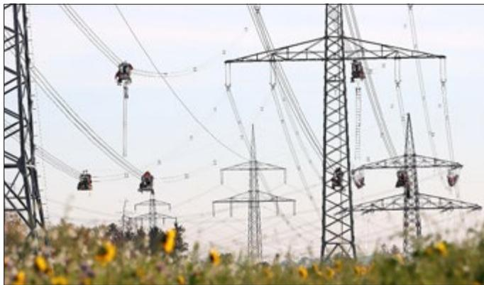
In luftiger Höhe montieren die Arbeiter von in den Leitungen eingehängten Wagen aus die Abstandshalter für die in Viererbündeln angeordneten Leiterseile. Foto: Mario Streit
