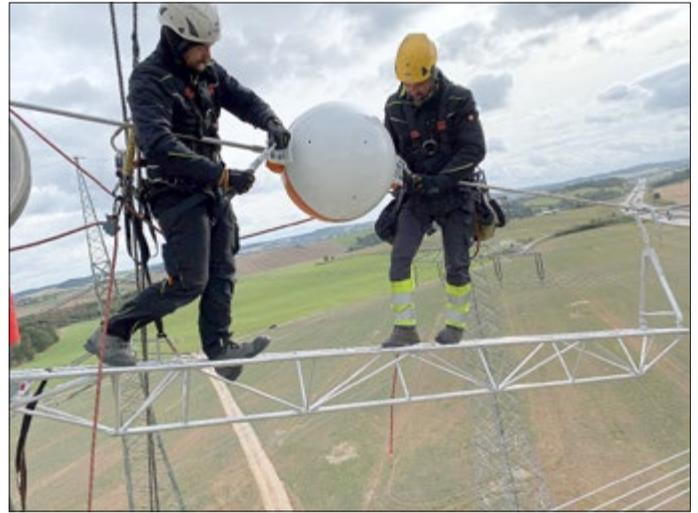
Arbeiter montieren die Flugwarnkugeln über der A9 zwischen Pörmitz und Neundorf. Sie sorgen für eine bessere Sichtbarkeit der Leitung, um Rettungshubschrauber bei einem notwendigen Einsatz auf der Autobahn zu warnen. Foto © 50herz
