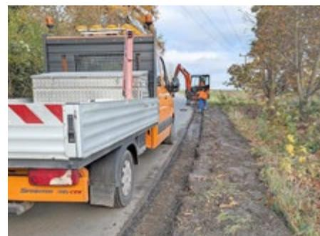
Das verbliebene alte Bankett wurde bis auf tragfähigen Untergrund abgetragen und der Untergrund für den Asphalteinbau vorbereitet.
